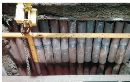
▶ Central Termoeléctrica Necochea, en la TV 4 el 14/8 comenzó el desarme del alternador para limpieza de cabezas de bobina por presentar altas descargas parciales. Fecha estimada de finalización 11/11.
